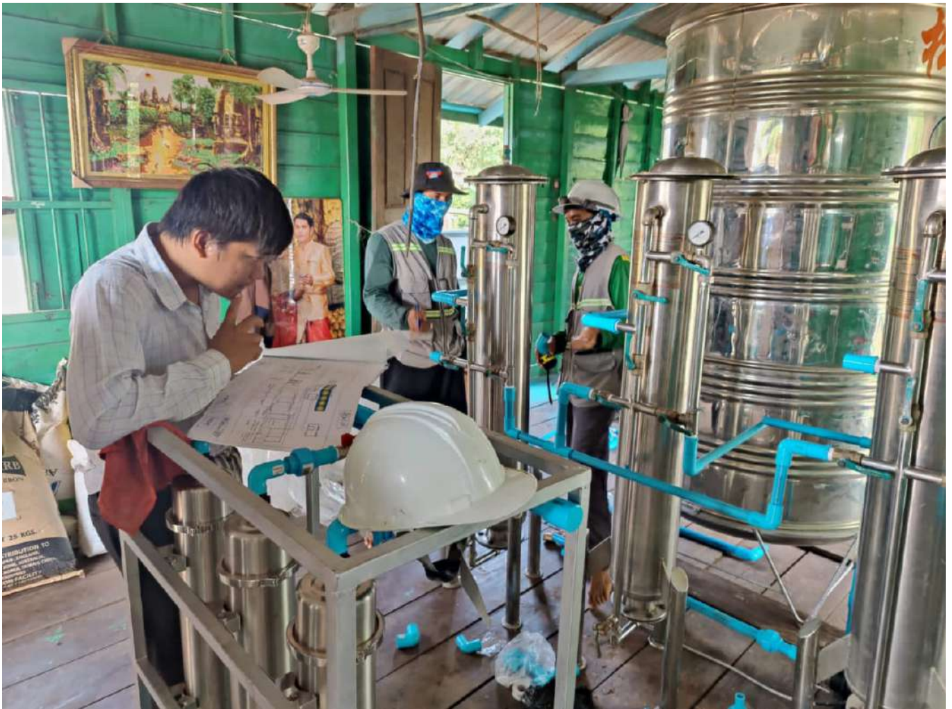
Montage d'une unité de production d'eau potable flottante par l'équipe cambodgienne. © SESAM
